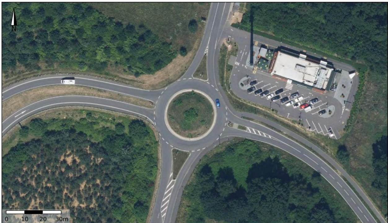
Abbildung 5: Ausbaustand des Knotenpunktes Nollesweg / Roermonder Straße / AS Elmpt (nördl. Rampen) (KP 3) (Luftbild: [2])
