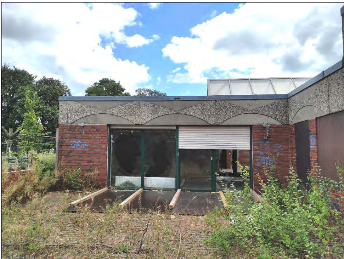
Bild 3: Sicht auf den nördlichen Bereich des Gebäudes aus westlicher Richtung (eigene Aufnahme, 27.07.2022)
