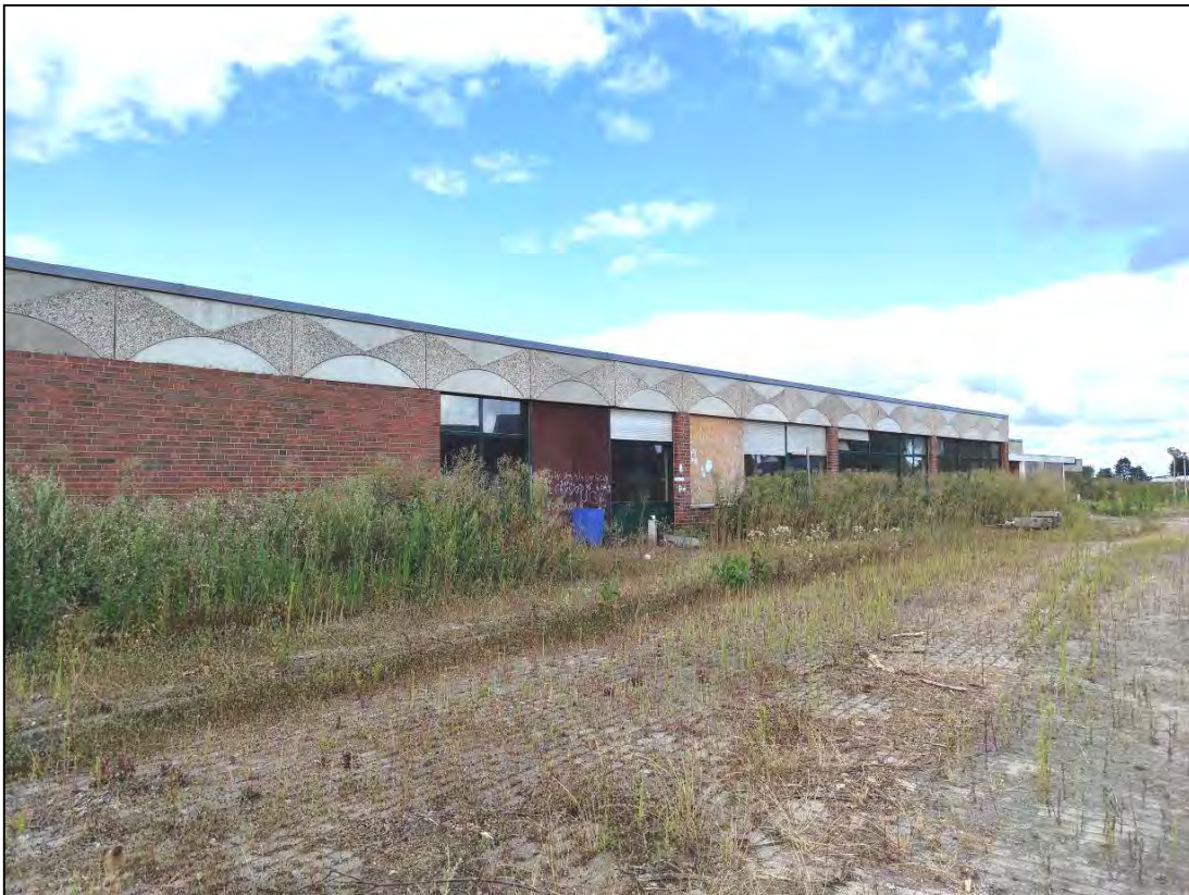
Bild 1: Ansicht des Gebäudes aus südöstlicher Richtung (eigene Aufnahme, 27.07.2022)
