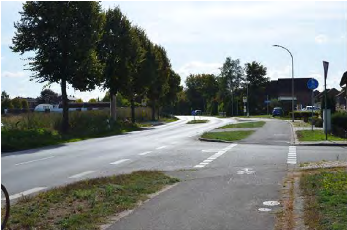
Bild 11 – Overhetfelder Str. Richtung Süden
