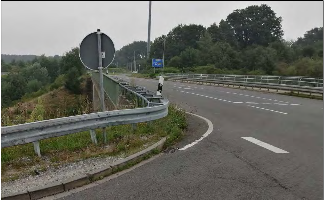
Abbildung 7: Eingeschränkte Sichtbeziehung am Knotenpunkt Nollesweg / AS Elmpt (südl. Rampen) (KP 2) (Aufnahme vom 17. August 2023)
