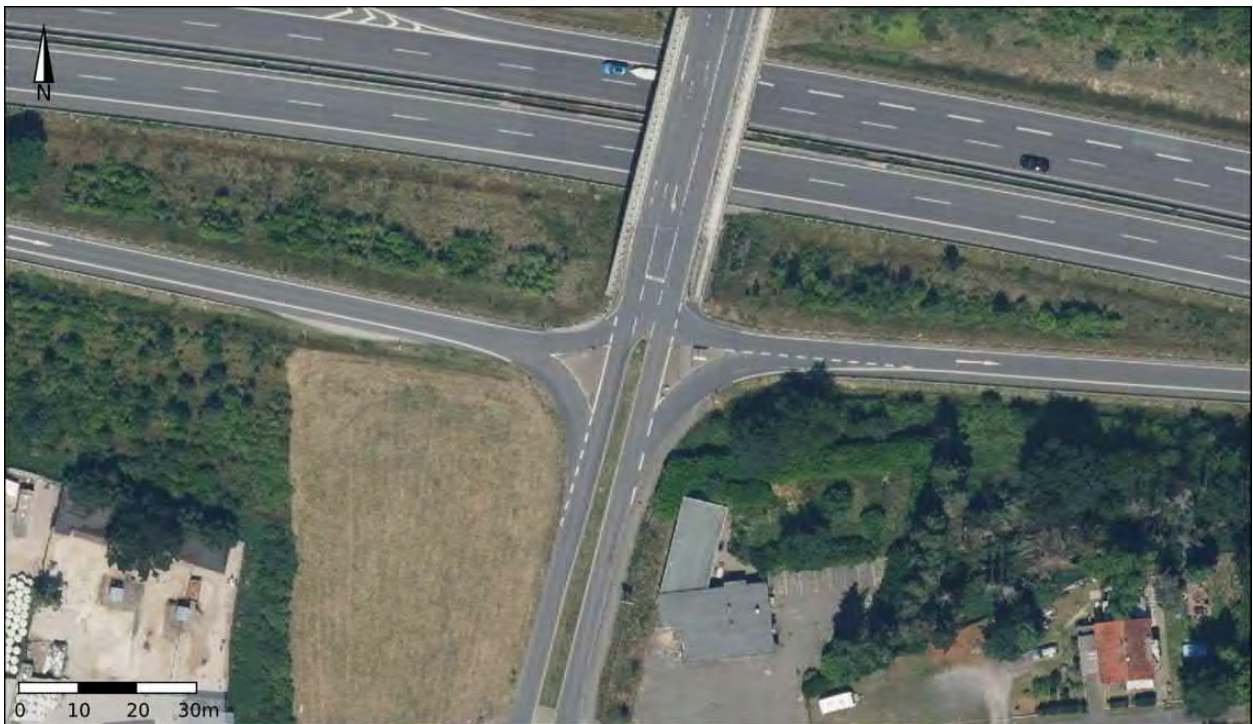
Abbildung 4: Ausbaustand des Knotenpunktes Nollesweg / AS Elmpt (südl. Rampen) (KP 2) (Luftbild: [2])
