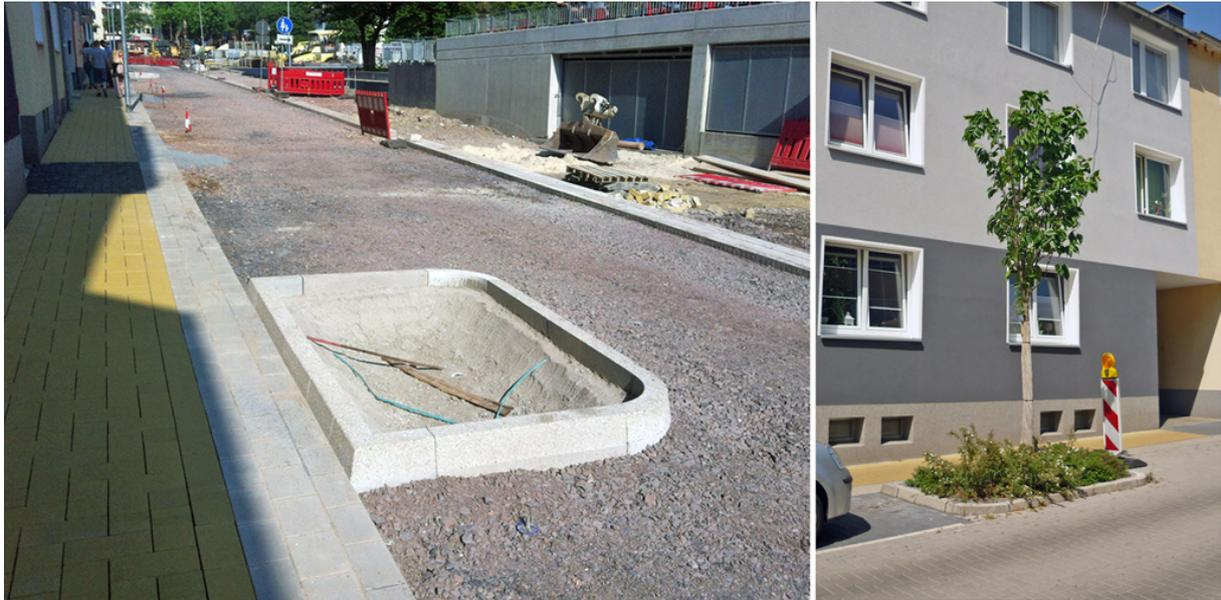
**Abb. 4.** Ergebnis der Anlage eines ungeeigneten Baumstandortes. Die mindestens notwendigen  $12 \text{ m}^3$  Wurzelraum wurden an dieser Stelle nicht einmal ansatzweise erzielt. Die Pflanzung eines Baumes ist an einem solchen Standort eine dauerhaft lediglich Kosten mit sich bringende, vollständig sinnlose Investition - da er sich noch nicht einmal notgedrungen aus eigenem Antrieb über die ihm aufgezeigten Grenzen hinaus entwickeln kann.
