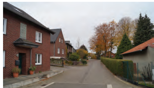
Bereits dorfgerecht ausgebaute Straße
