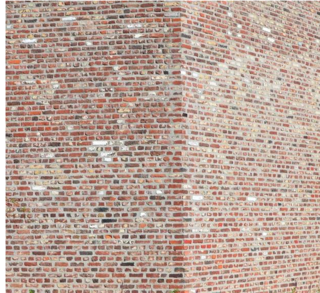
[7] Fassade mit gebrauchten Ziegeln (Museumsinsel Hombroich)
