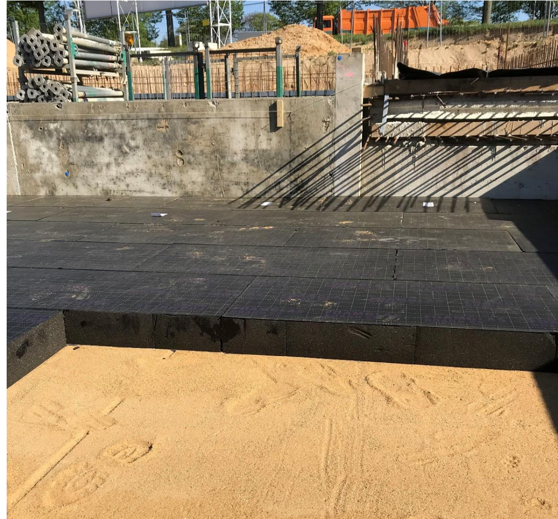
[4] in Sand gebettet Schaumglasdämmung (Kreis Viersen)
