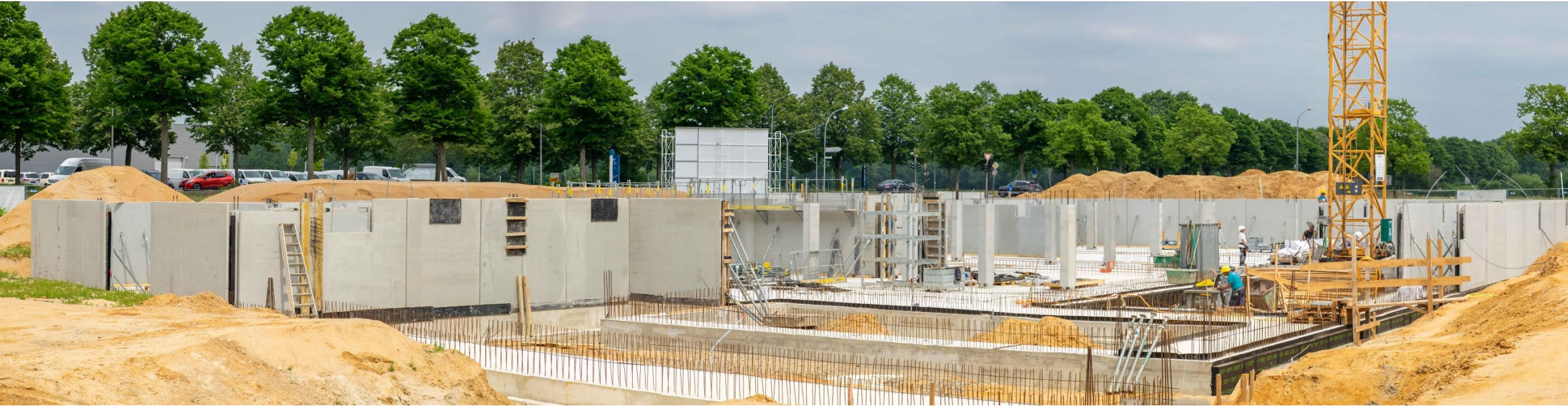
[3] Baustelle Kreisarchiv (Foto: Bruno Wesch)
