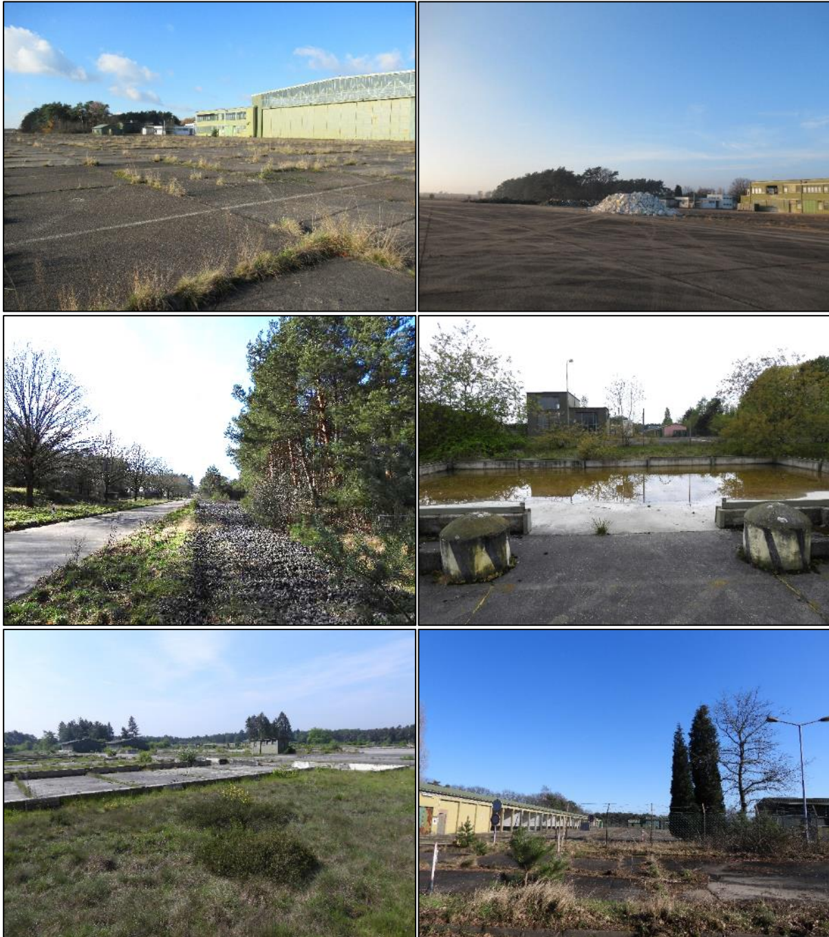
Abbildung 9: Großflächige Versiegelungen und Hallen im Süden und Nordwesten des Plangebietes
