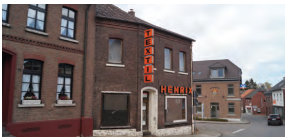
Gewerblicher Leerstand; Umbau zu Mehrfamilienhaus geplant
