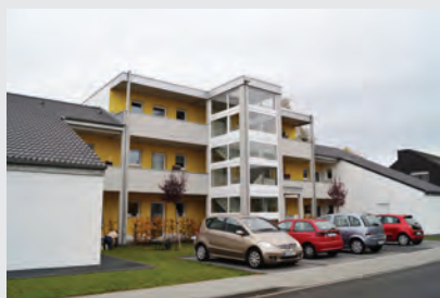
Elmpt, Uhlandstraße: Projekt Ev. Kirche
