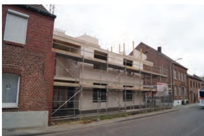
Neubau im Bestand
