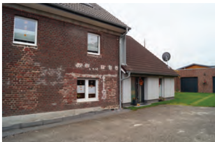
Neubau im Ortskern
