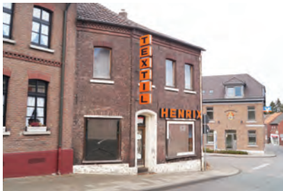
Leerstand in ehem. gewerblicher Nutzung (Mittelstraße, Alt-Niederkrüchten)
