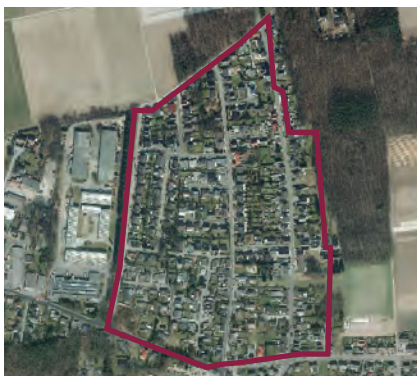
Luftbild Quartier in Elmpt (Quelle: Geoportal Gemeinde Niederkrüchten)
