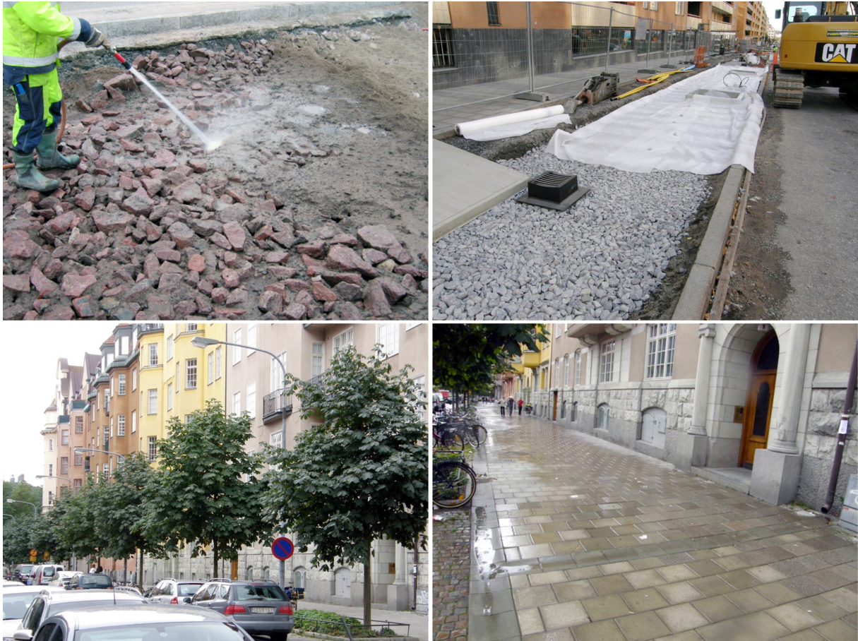
Abb. 5. Die Verfüllung der Baumrigolen erfolgt mit einer Skeletterde. Sie besteht in Schweden aus einem grobkörnigen Granit, in den ein Feinboden lagenweise mit hohem Wasserdruck eingeschwemmt wird (oben links). Die oberste Auflage bildet ein Grobschotter, über den die überdimensionalen Pflanzgruben entlüftet werden. Auf dieser Lage erfolgt der reguläre Wegeaufbau (oben rechts). Die Anlagen können mit jeder beliebigen Baumart bepflanzt werden. Durch die hervorragenden Eigenschaften der Standorte, haben beispielsweise auch Berg-Ahorne wieder eine langfristige Perspektive im innerstädtischen Bereich (unten links). In Stockholm wird unter anderem der Dachabfluss von den Fallrohren über den Gehweg in die Pflanzgruben geleitet (unten rechts).
