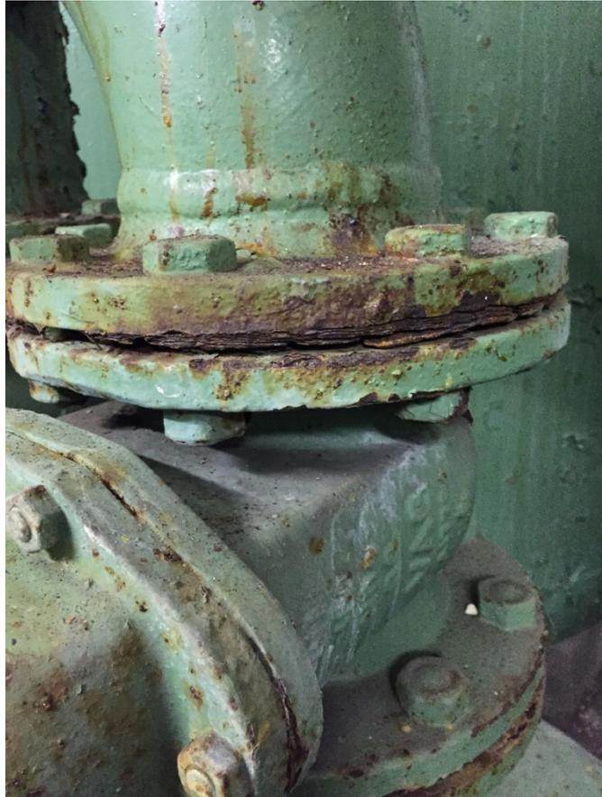
**Die Chlordosieranlage ist veraltet und entspricht nicht dem Stand der Technik.
