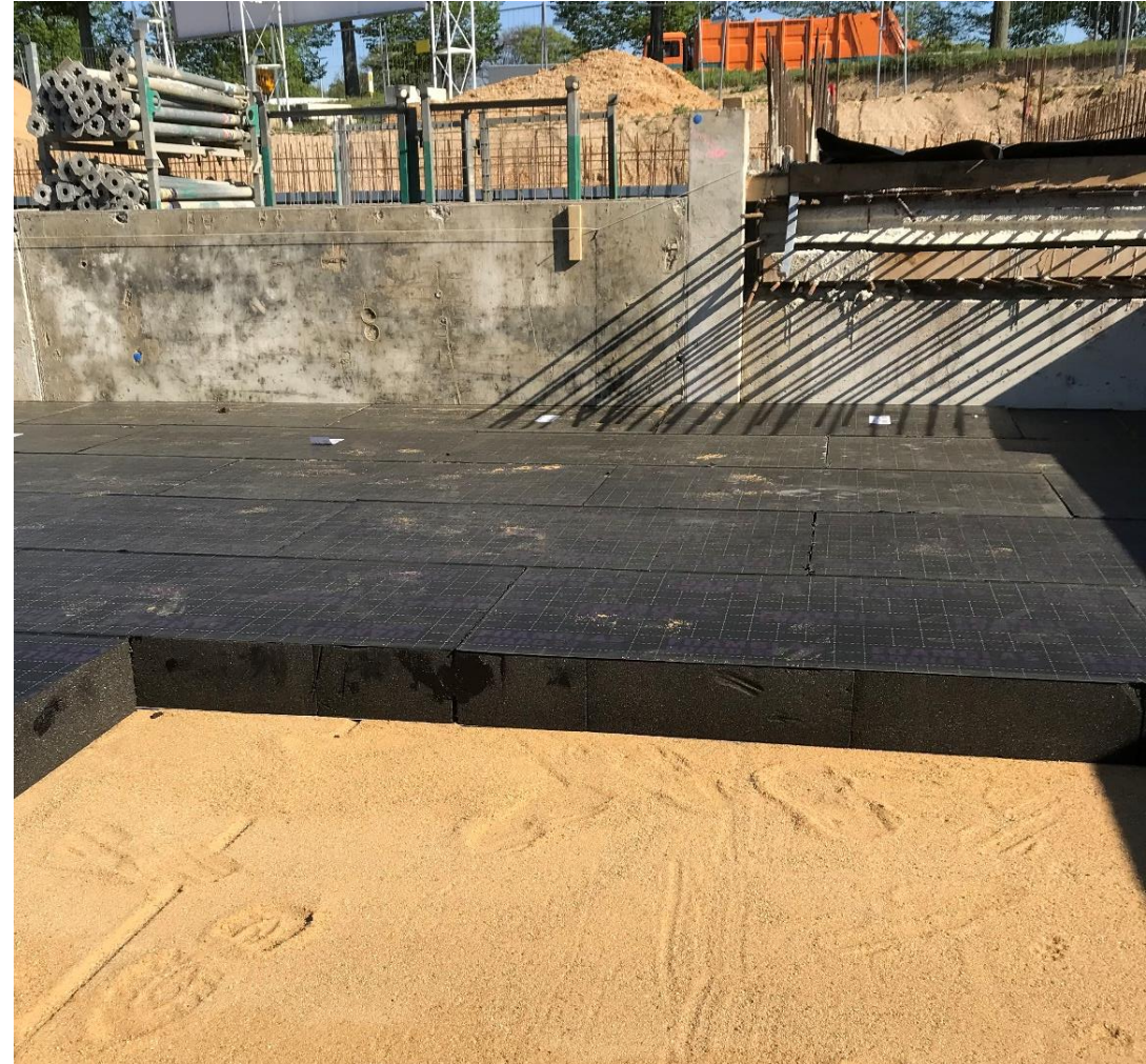
[4] in Sand gebettet Schaumglasdämmung (Kreis Viersen)
