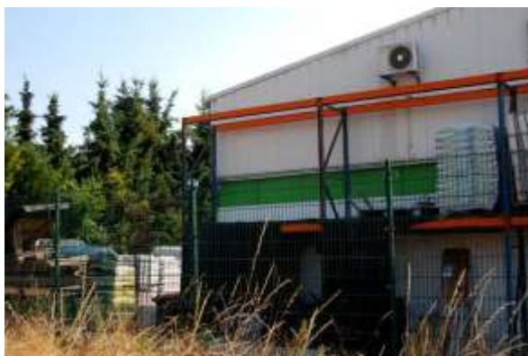
Westseite des Raiffeisenmarktes mit Hochregallager, links Fichtenhecke des nördlichen Nachbargrundstücks
