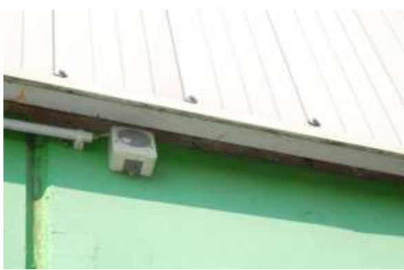
Geschlossene Abdichtung der Giebelkonstruktion
