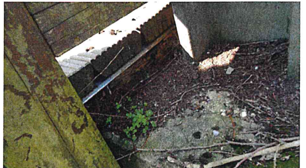
AUFLAGERBEREICH VERROTTET
