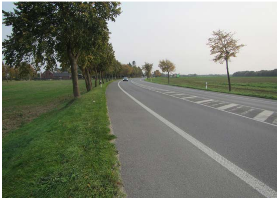
Abbildung 6-3: Mehrzweckstreifen an der B 221
