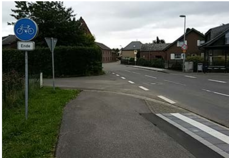
Abbildung 6-18: Radverkehrsinfrastruktur endet ohne Querungshilfe am Ortseingang von Boscherhausen
