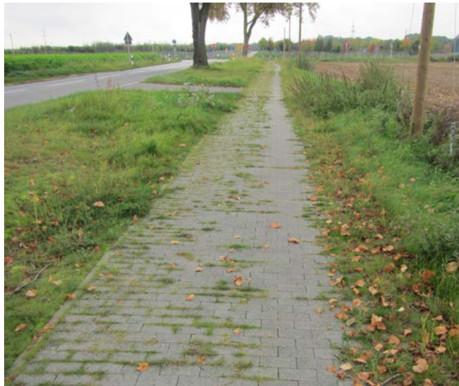
Abbildung 6-1: Oberflächenmängel an gepflasterter Radverkehrsinfrastruktur außerorts
