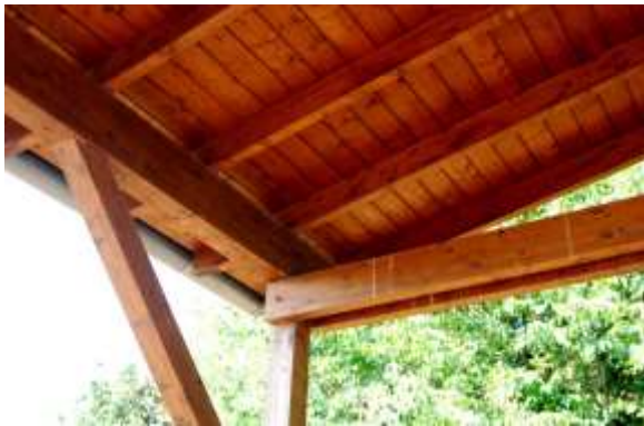
Dachkonstruktion im Bereich Laderampe, keine Vogelnester vorhanden
