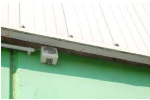
Geschlossene Abdichtung der Giebelkonstruktion
