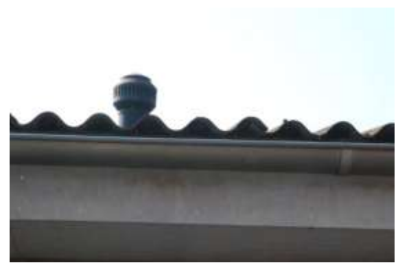
Abdichtung der Welldachenden mit Kunststoffelementen
