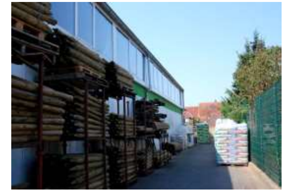
Lagerflächen an der Nordseite (Raiffeisenmarkt)
