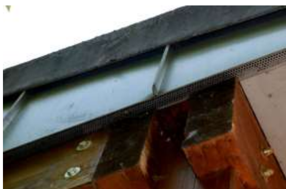
Abdichtung der randlichen Dachunterseite vollkommen geschlossen mit Lochblechen und Kunststoffprofilen
