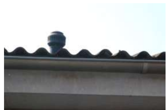
Abdichtung der Welldachenden mit Kunststoffelementen
