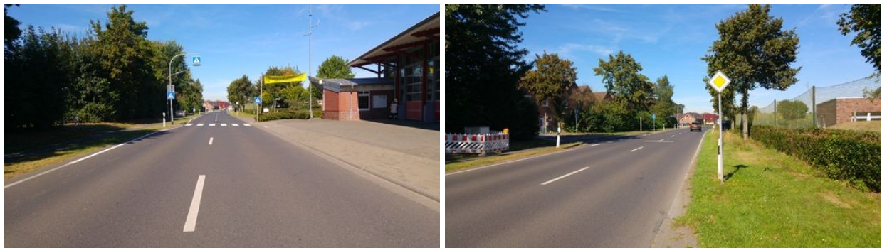
Abbildung 4: Overhelfelder Straße im Bereich der Einmündung Florianstraße, Blickrichtung Norden. Links: vorhandener Fußgänger-Überweg. Rechts: Fehlender Gehweg am östlichen Fahrbahnrand in Höhe des DRK-Kindergartens.
