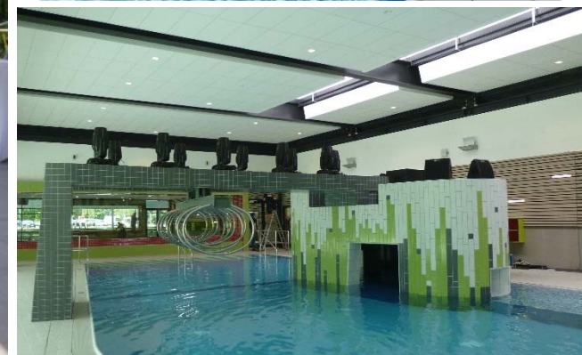
Cabriodach (Stadtbad Okeraue Wolfenbüttel)
